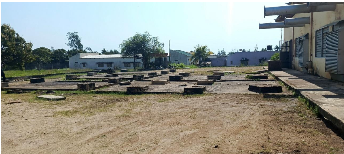
Figura 5 – Área reservada para a implantação da subestação
