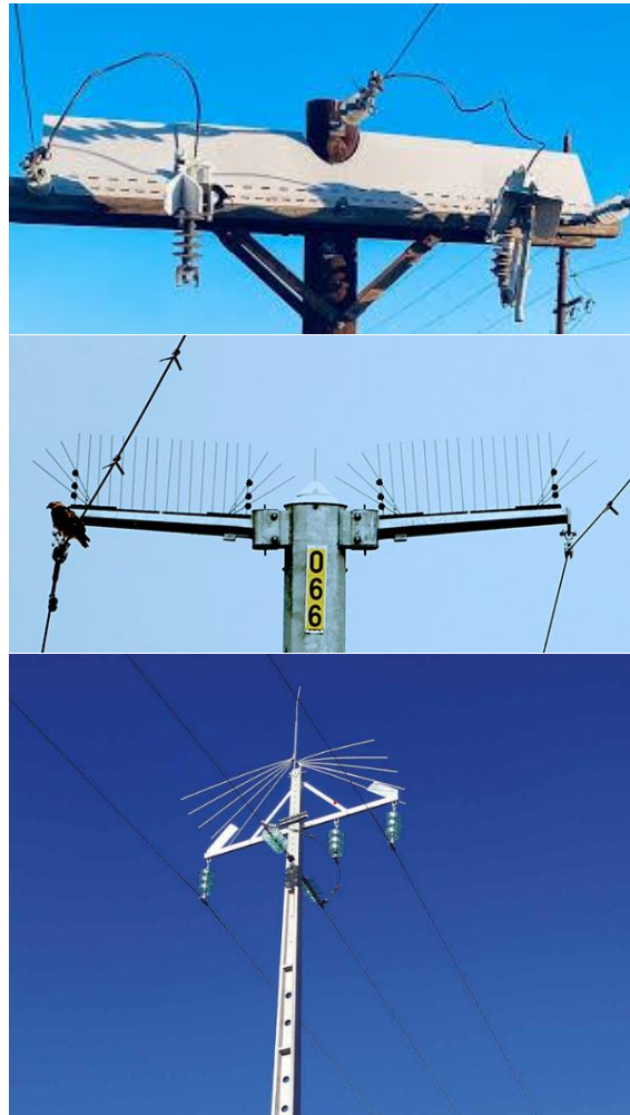
Figura 9 - Exemplos de dispositivos anti-pouso e anti-ninho
